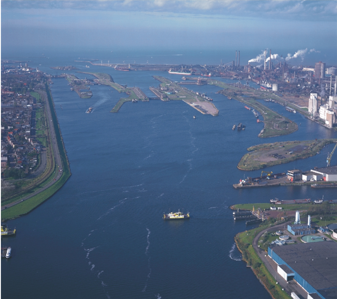
Zeesluizencomplex en gemaal (rechts van zeesluis) bij IJmuiden
